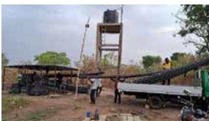
Bau des Trinkwasserbrunnens
